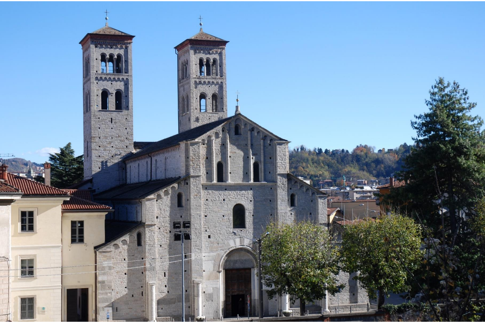
Como - Basilica di Sant'Abbondio
